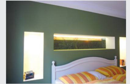
Rückwand mit Regalnischen und indirekter Beleuchtung (Trockenbau), Zierprofileleisten als Deckenabschluss, starke zweifarbige Farbgebung als Sonderfläche
