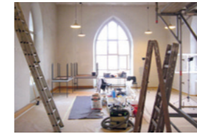
Kirchsaal während der Arbeiten
