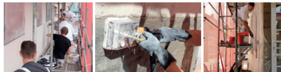
Putzarbeiten an der Fassade
